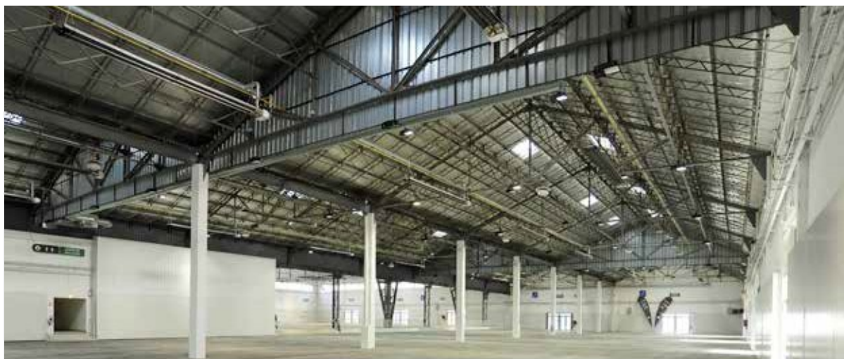
Zone A au premier plan. A gauche, dans le fond du bâtiment, la zone B. A zone
