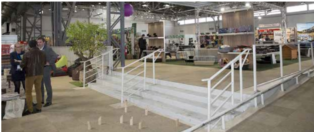
Le garde-corps, visible sur la gauche, délimite les zones A et B (0,50m de différence de hauteur) A fence is separating zones A and B due to the 0,50m level difference
