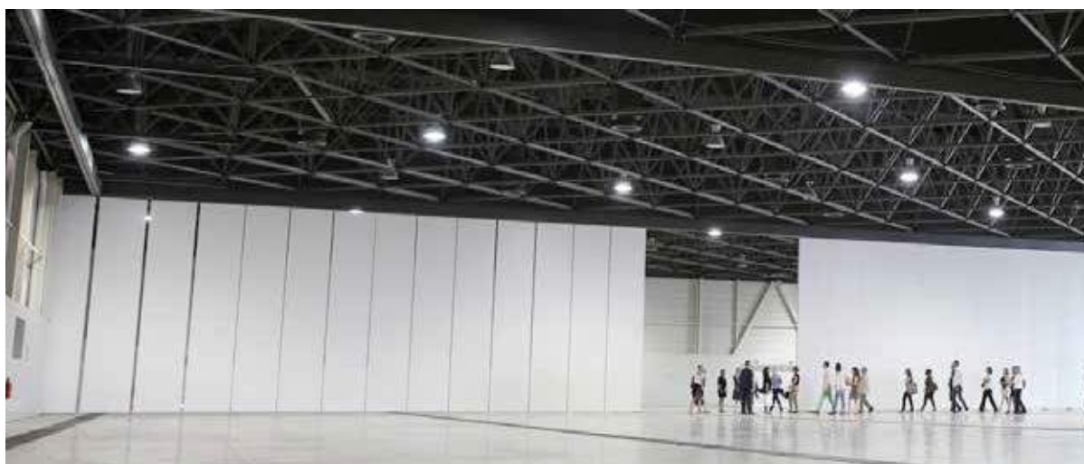
Mur mobile positionné en A – Fractionné en 2 parties (Photo : SAFIM/ B. RUIZ) Installation of part of the wall
