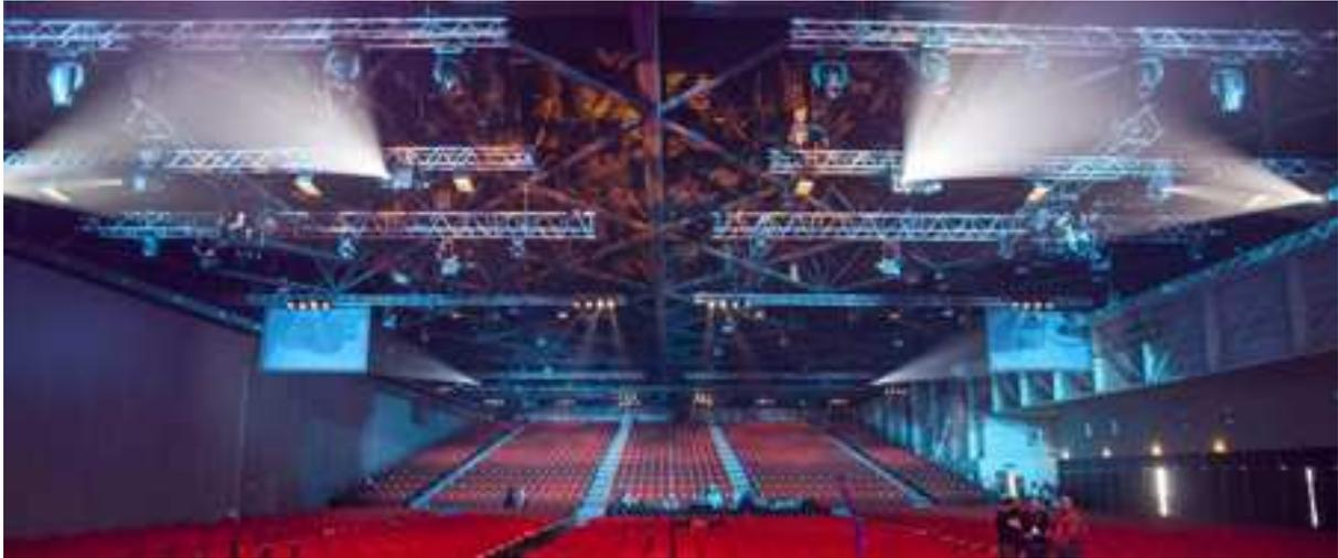
*Les ponts en 2 parties permettent d'échapper à la retombée du rail du mur mobile (8,25m)
