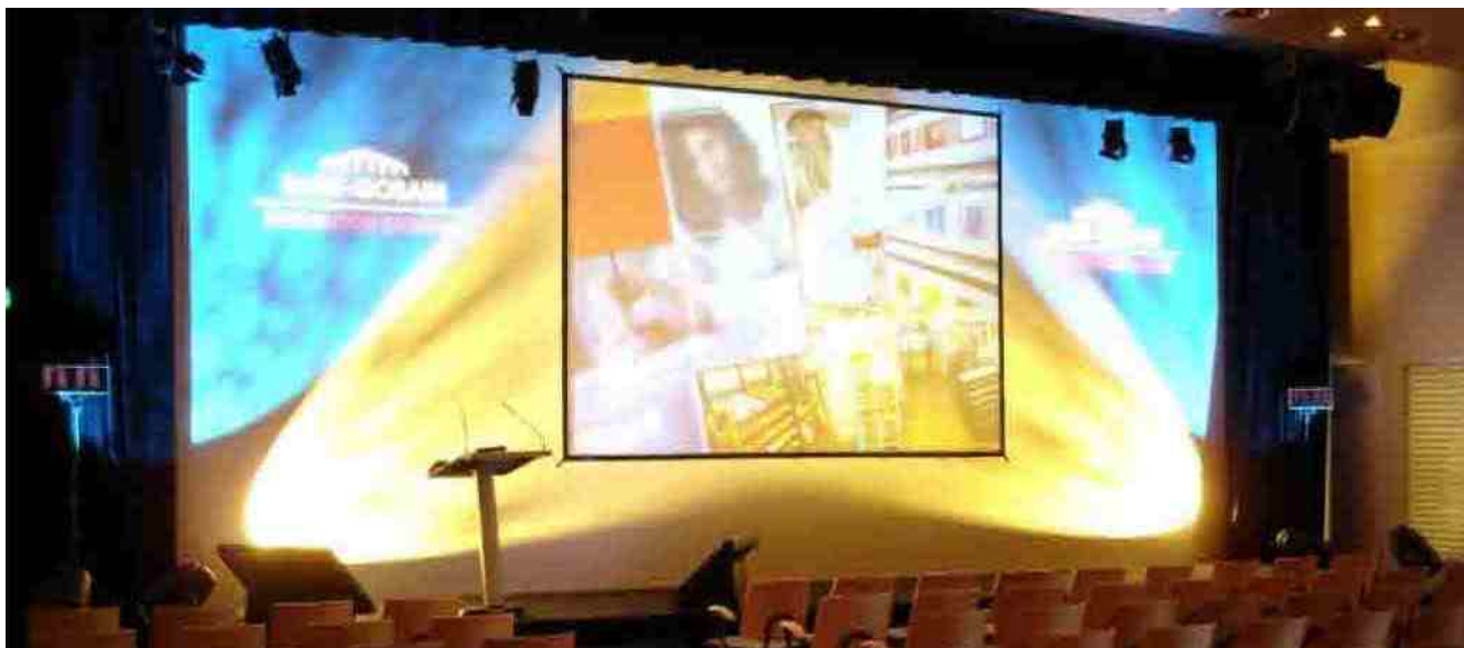
Rideau de fond de scène ouvert - mur blanc du lointain utilisé comme support pour l'éclairage et la projection de gobos – un écran cadre, installé sous la perche électrique, permet de décrocher la projection vidéo – la frise située devant la perche électrique est fixe (Saint-Gobain Distribution Bâtiment)
