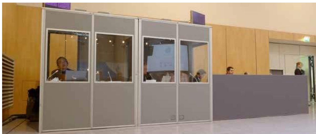
Salle Les Goudes 2 – Installation de cabines de traduction et d'une régie en fond de salle «Les Goudes » room 2 – control and interpreter booths in the back of the room.
