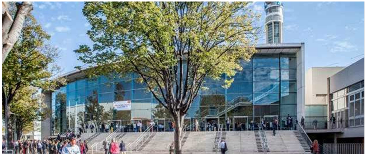
Accès au foyer de l'auditorium 1200 places
