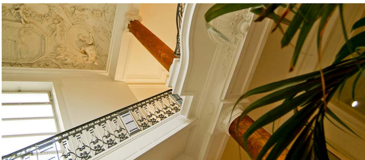
Escalier monumental permettant l'accès au hall du 1 er étage
