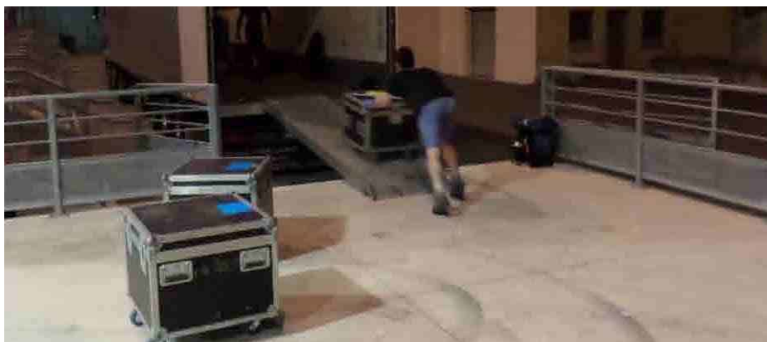
La rampe de livraison en zone A est également équipée d'un quai de livraison par simple démontage du garde-corps (Photo SAFIM)
