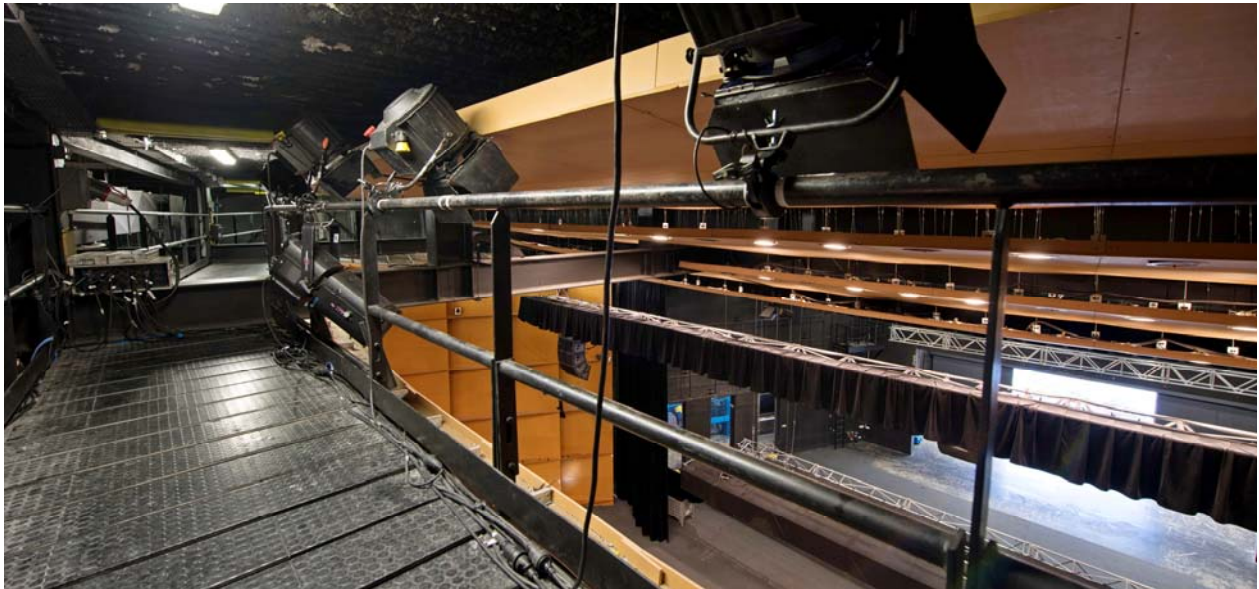
Lisses inférieures passerelle B en position basse pour installation découpes Lowers guardrails catwalk B in lower position for profile projectors
