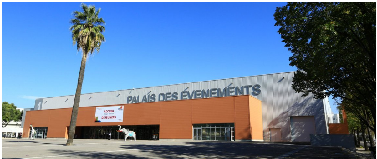
Convention APM – Façade ouest - Entrée Porte 1A (Photo : SAFIM / C. MOIRENC)
