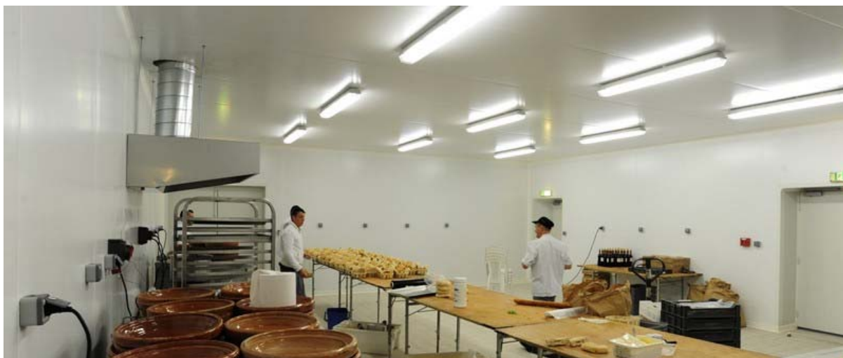
Des PC 10/16A sont spécialement disposées sur un des murs latéraux pour le raccordement des étuves et des percolateurs (3.6 kW disponibles par PC)
