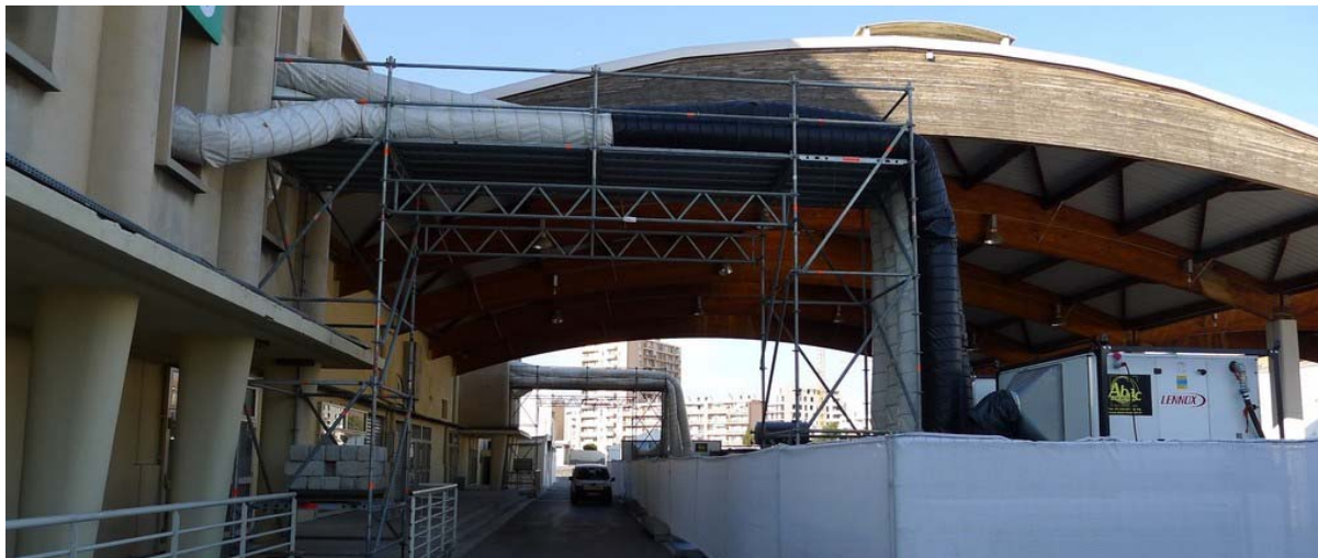
Les gaines souples passent au-dessus de la voie pompiers. World Water Forum (photo : SAFIM / OD)
