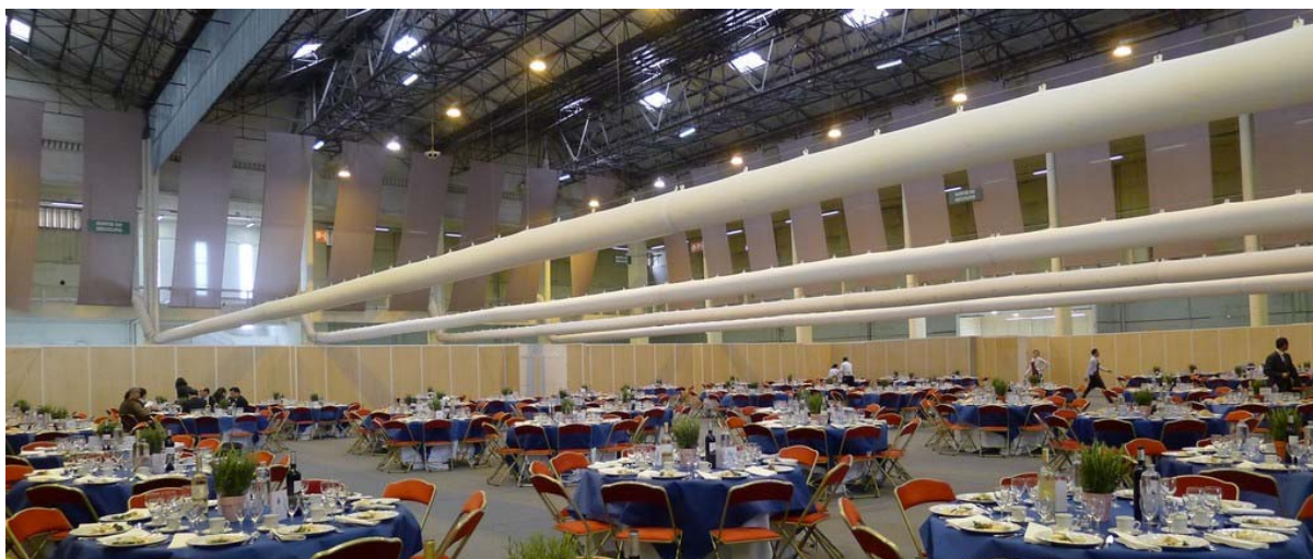
World Water Forum – Installation de gaines. La hauteur des gaines peut varier selon l'utilisation : chauffage ou climatisation. (Dimension : 3m)
