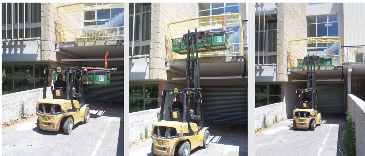
Accès matériel par la barrière éclose / Hauteur de levage : 4,20m Unloading platform - Fork-lift truck is necessary : lift height : 4,20m
