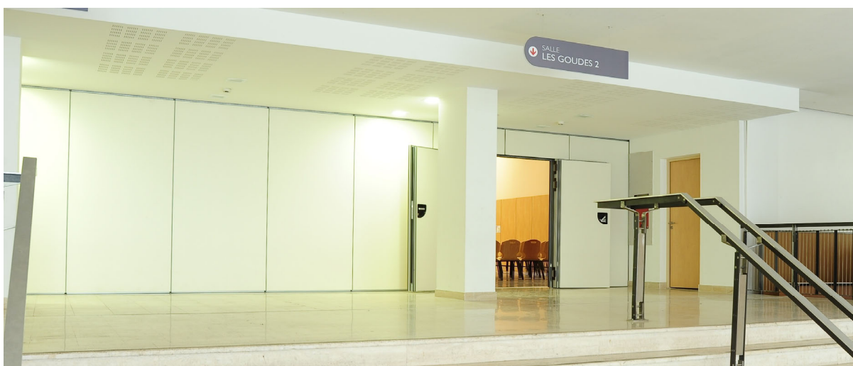
Le petit mur mobile de séparation entre le Hall Accueil Expo et la salle Les Goudes. Ce mur mobile est mis en place quand il est nécessaire d'isoler la salle Les Goudes du reste du 1 er étage The small mobile wall separates "Les Goudes" room from the rest of the "Hall Accueil Expo" 1st floor
