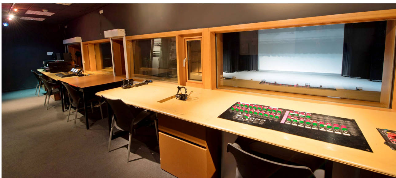
Régie AV Control room
